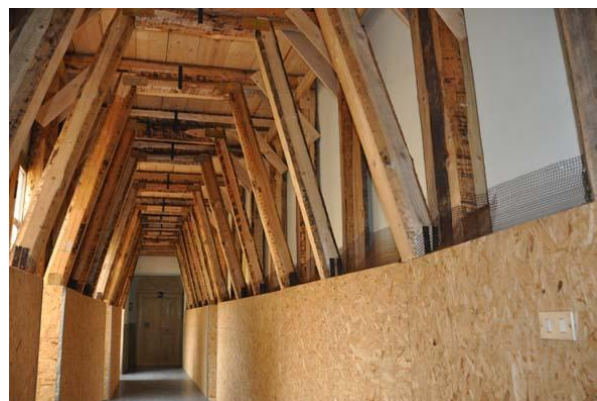
Un corridoio del Convitto Tulliano con le strutture provvisorie di sostegno
